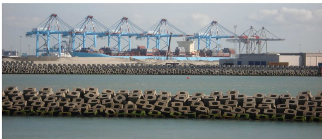
Figuur 1: Illustratie dijkversteving met zware betonelementen [6].
